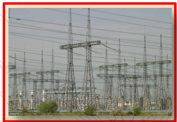
Открытое распределительное устройство подстанции
