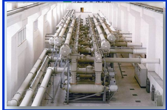
Распределительное устройство подстанции в компактном исполнении
